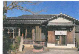
現在は瓦葺きになり、玄関部分も増築されている
