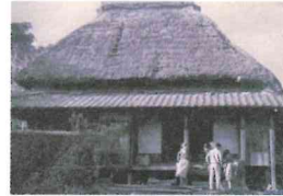
昔は麦カヤ葺きの屋根で、濡れ繕だった。昭和30年代(約70年前)の写真
